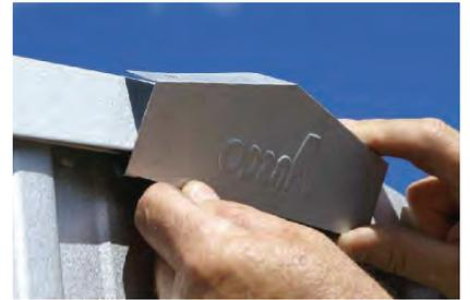
図のように上部フランジと下部フランジを曲げ、次に下部フランジを上部チャンネルの下に引っ掛けて、2つのねじで棟梁に上部をねじ込みます。
